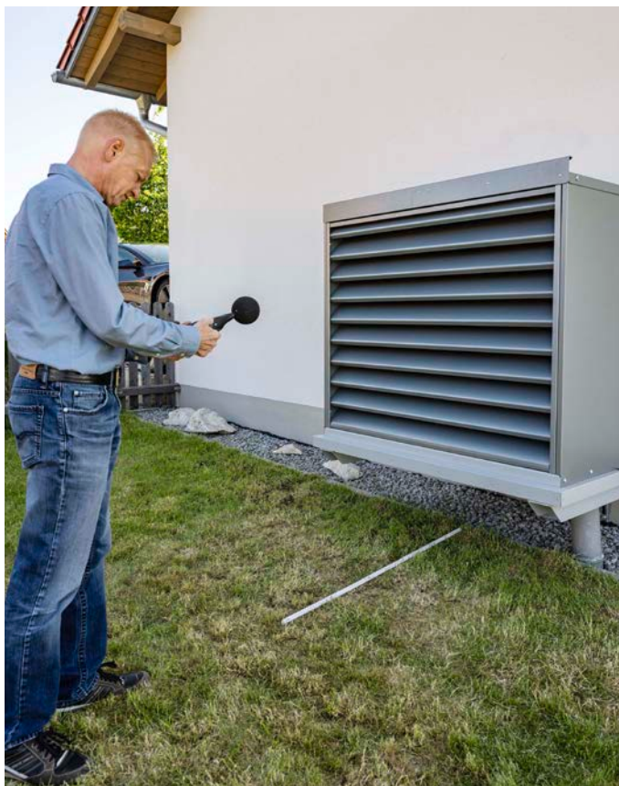
Ist eine Schallschutzhaube optimal ausgelegt, kann sie den Schalldruckpegel um bis zu 20 Dezibel reduzieren.
